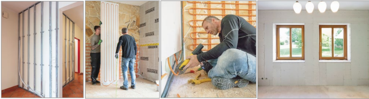
Einfache Montage der Trockenbau-Wandheizung/Kühlung: 1. Unterkonstruktion an die Wand schrauben, 2. Modulplatten an der Unterkonstruktion montieren. 3. Heizungsrohre mittels Presskupplungen verbinden. Fertig ist der Raum zum Verspachteln.
