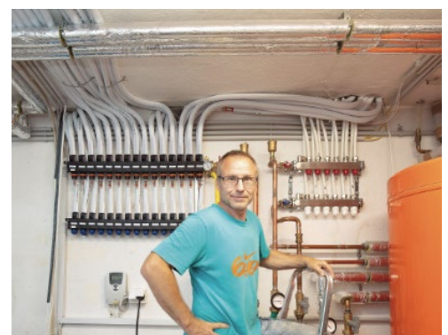
In nur 14 Tagen war die Heizungssanierung beendet.
