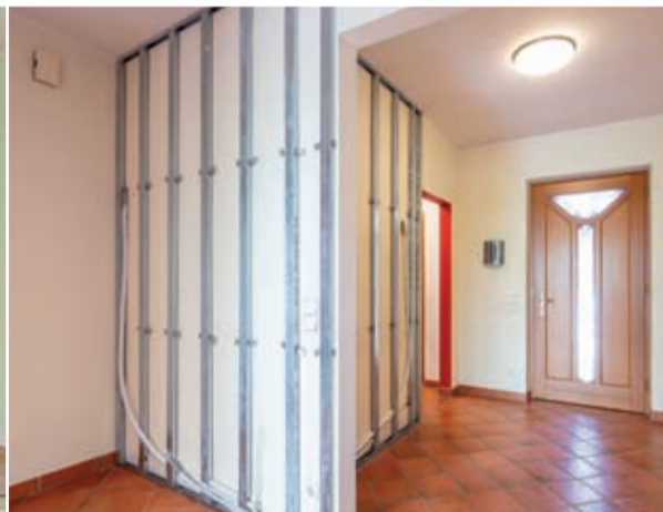
Montage der U- und C-Profile im Eingangsbereich
