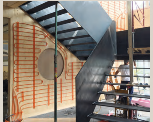
Auch der maschinell verarbeitete Lehmputz ...
