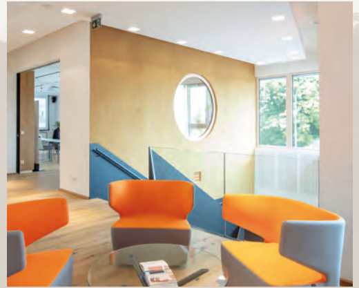
Fertige EasyFlexWand mit Lehmputz
