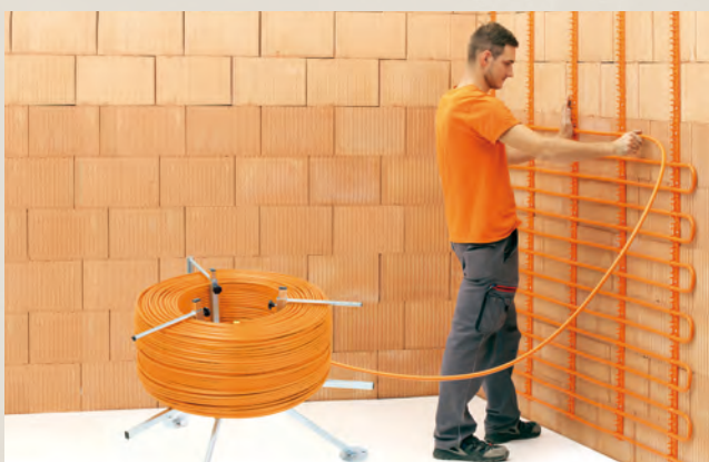
Einfach und durchdacht ist die Montage einer EasyFlexWand.
