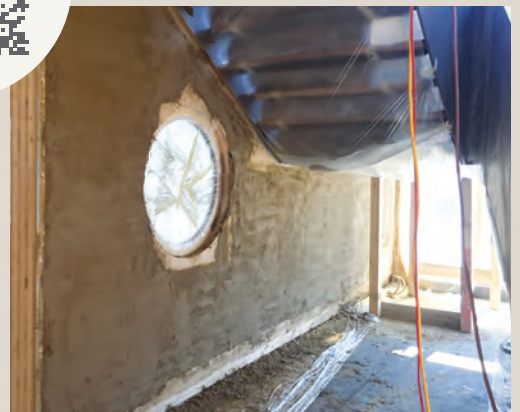
... für gesundes Raumklima – wohnfertig in 3 Tagen!
