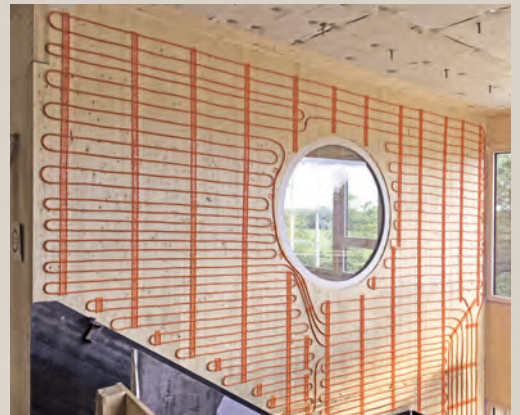
Montage der EasyFlexWand
