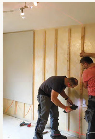
... einfach höher montiert wurde.
